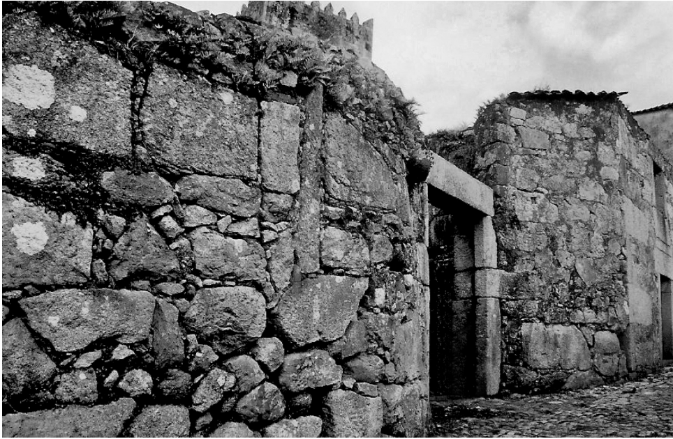
Fig. 7 – Casa da Rua do Rio onde se fez a intervenção arqueológica
