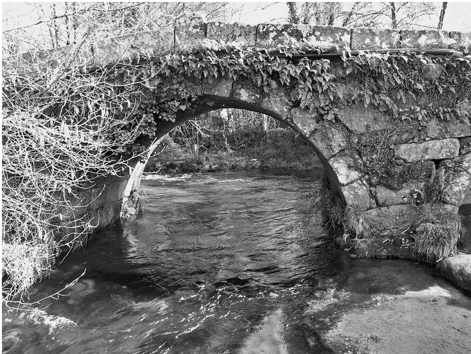
Fig. 19 – Tropoz - Arco redondo da Ponte da Igreja
