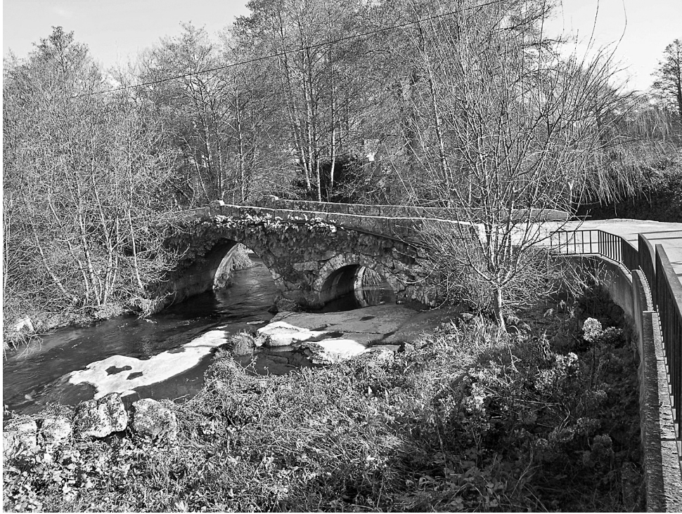
Fig. 18 – Tropoz - Ponte da Igreja. Construção em leve cavalete do séc. XV/XVI
