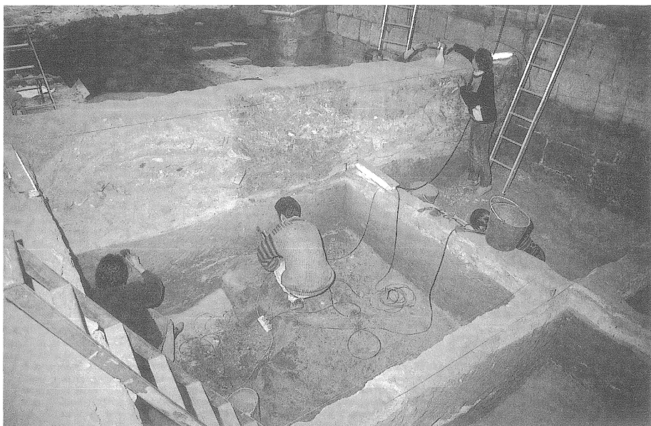
Fig. 4 — Vista dos trabalhos de escavação na zona da Torre Sul.
